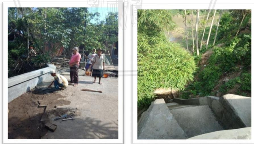
**Gambar 11. Pembangunan Talud/Plengsengan penanganan tanah longsor (bencana**
