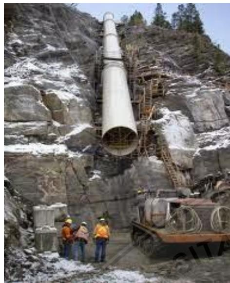
Gambar 2.2. Pipa Pesat pada PLTM
