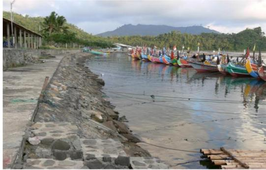
Gambar 13 Revetment Pelabuhan Perikanan Pantai Tamperan
