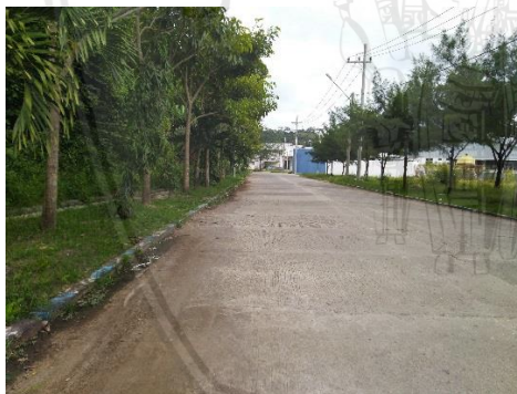
Gambar 8. Jalan Komplek Pelabuhan (Data Primer, 2019).
