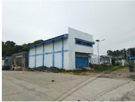
Gambar 15. Gedung processing (Data Primer, 2019).
