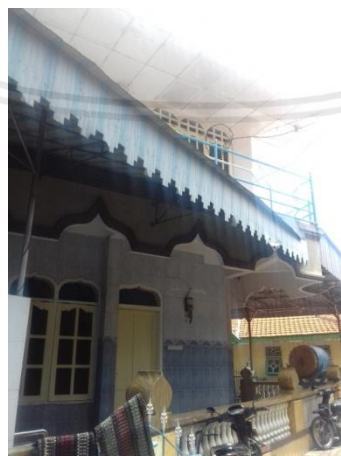
Gambar 10. Masjid Tempat Istigosah Sumber: Dokumentasi Penelitian, 2019
