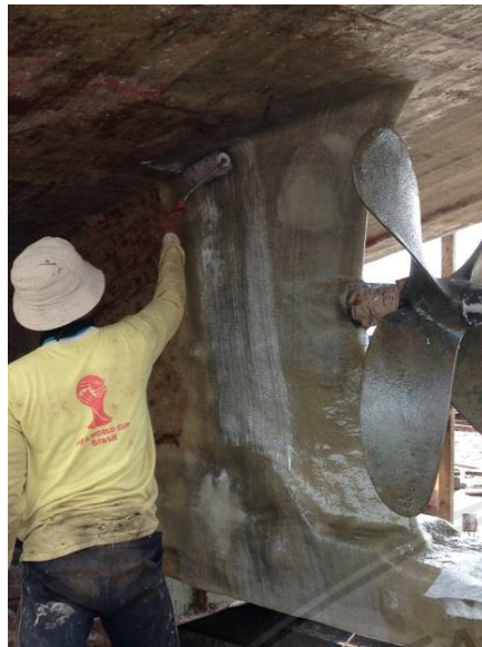
7. Proses pelapisan fiber pada badan kapal
