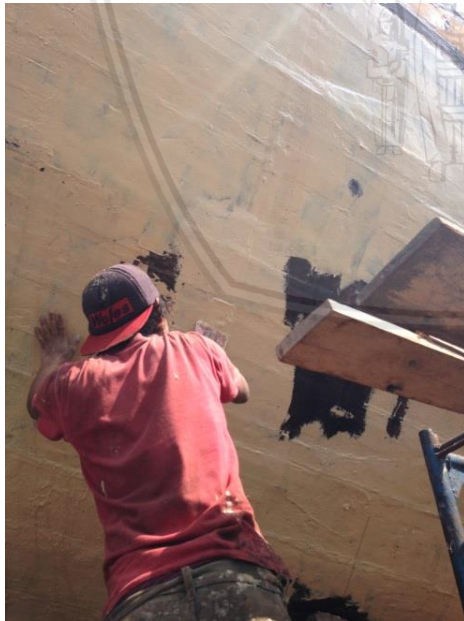
6. Pendempulan papan kayu kapal yang selesai diperbaiki
