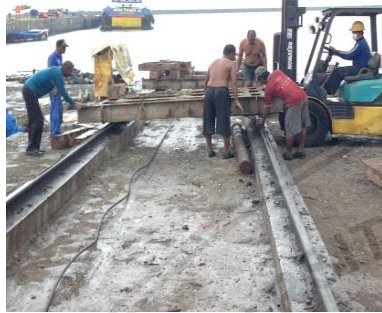
1. Proses penyetelan lori (kereta) dan pelumasan rel slipway
