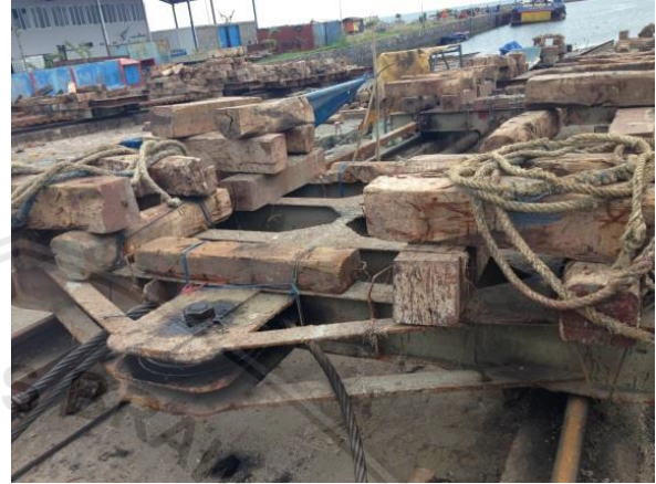
1. Proses penyetelan lori (kereta) dan pelumasan rel slipway
