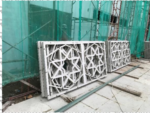
Gambar 4.46 Perlindungan Material GRC
