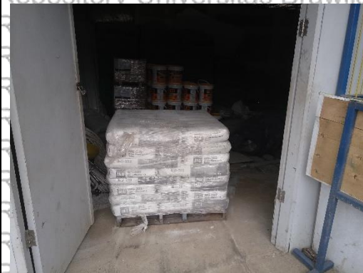
Gambar 4.53 Packing Plastik Untuk Perlindungan Material
