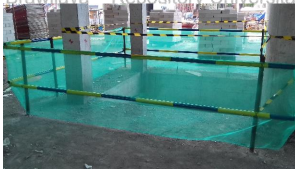
Gambar 4.144 Pemanfaatan Sisa Material Besi Hollow Sebagai Railing Pengaman
