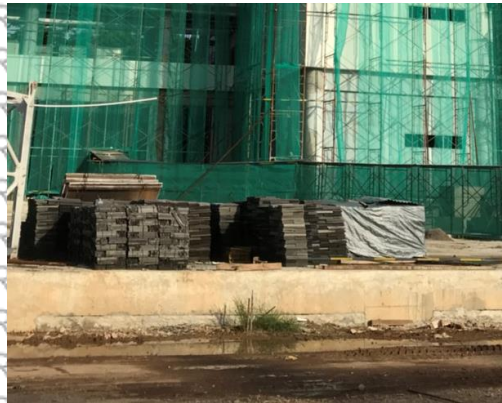
Gambar 4.47 Perlindungan Material Batu Alam
