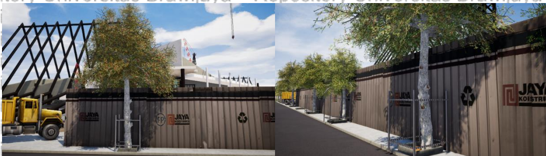
Gambar 4.156 Rekomendasi Tree Steger Menggunakan Sisa Material Besi Hollow
