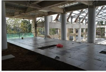
Gambar 4.126 Pekerjaan Keramik
