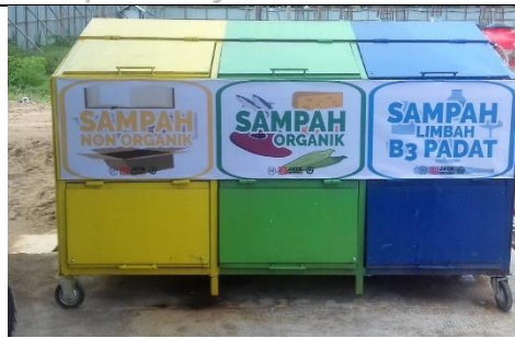
Gambar 4.76 Pemilahan Sampah Konstruksi Sesuai Jenisnya Dengan Menyediakan 3 Tempat Sampah Untuk Masing-Masing Jenis Sampah Konstruksi
