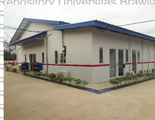
Gambar 4.103 Kontraktor Keet Tidak Menggunakan Material Asbes
