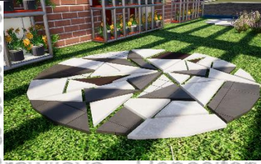
Gambar 4.185 Alternatif 2 Rekomendasi Pemanfaatan Sisa Material Keramik Melalui Proses Upcycle
