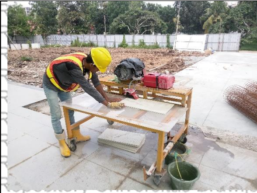
Gambar 4.69 Optimalisasi Limbah Besi Hollow Menjadi Meja Dudukan Pabrikasi Step Nosing Keramik
