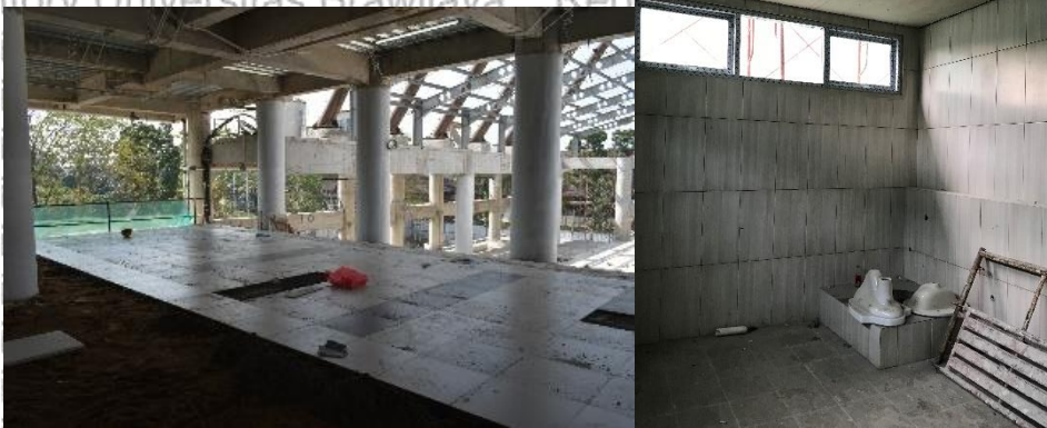
Gambar 4.138 Pekerjaan Pemasangan Keramik
