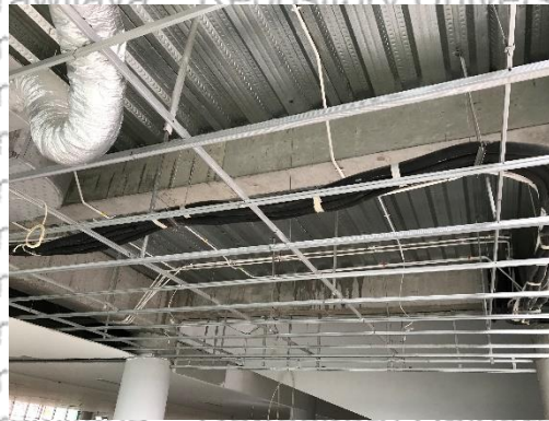
Gambar 4.143 Pemotongan Besi Hollow Pada Pekerjaan Plafond
