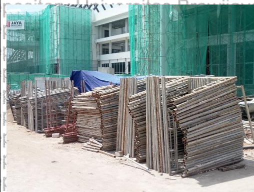
Gambar 4.50 Perlindungan Material Menggunakan Terpal
