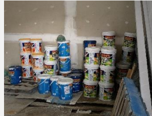
Gambar 4.132 Pekerjaan pengecatan Dan Material Cat
