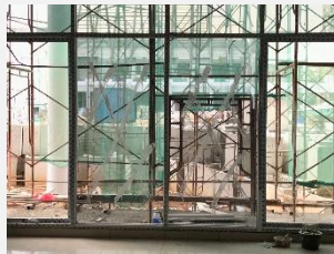
Gambar 4.133 Pekerjaan Kaca Dan Cermin
