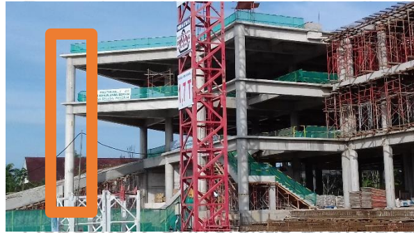
Gambar 4.60 Kolom Dengan Metode Prefabrikasi
