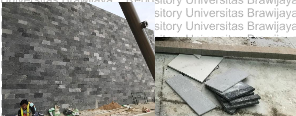
Gambar 4.140 Sisa Material Pada Pekerjaan Pemasangan Batu Alam
