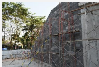
Gambar 4.127 Pekerjaan Batu Alam
