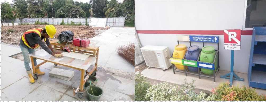
Gambar 4.145 Pemanfaatan Sisa Material Besi Hollow Sebagai Dudukan
