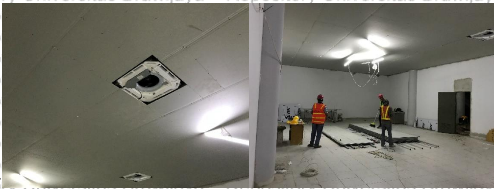
Gambar 4.142 Pemotongan Material Kalsiborad Pada Pekerjaan Plafond
