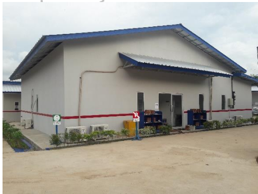
Gambar 4.56 Kontraktor Keet Sebagai Fasilitas Sementara
