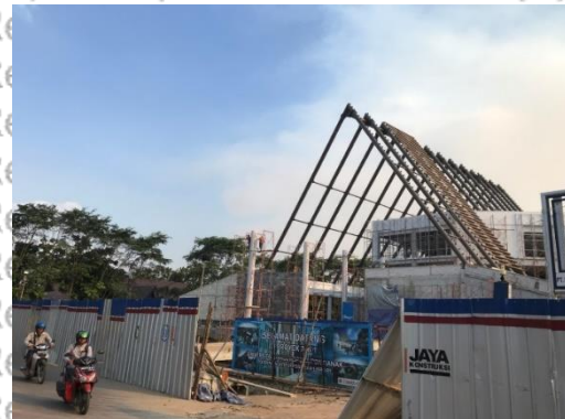
Gambar 4.2 Kondisi Eksisting Proyek Saat Penilaian
