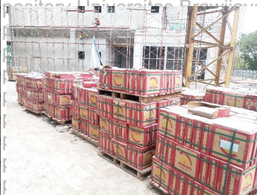
Gambar 4.51 Perlindungan Material Keramik
