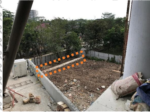
Gambar 4.12 Saluran Air Yang Terhubung Dengan Riul Kota
