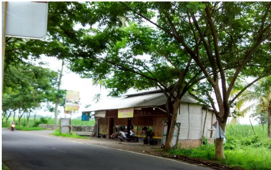
Gambar 28. Bangunan yang melanggar batas jalan
