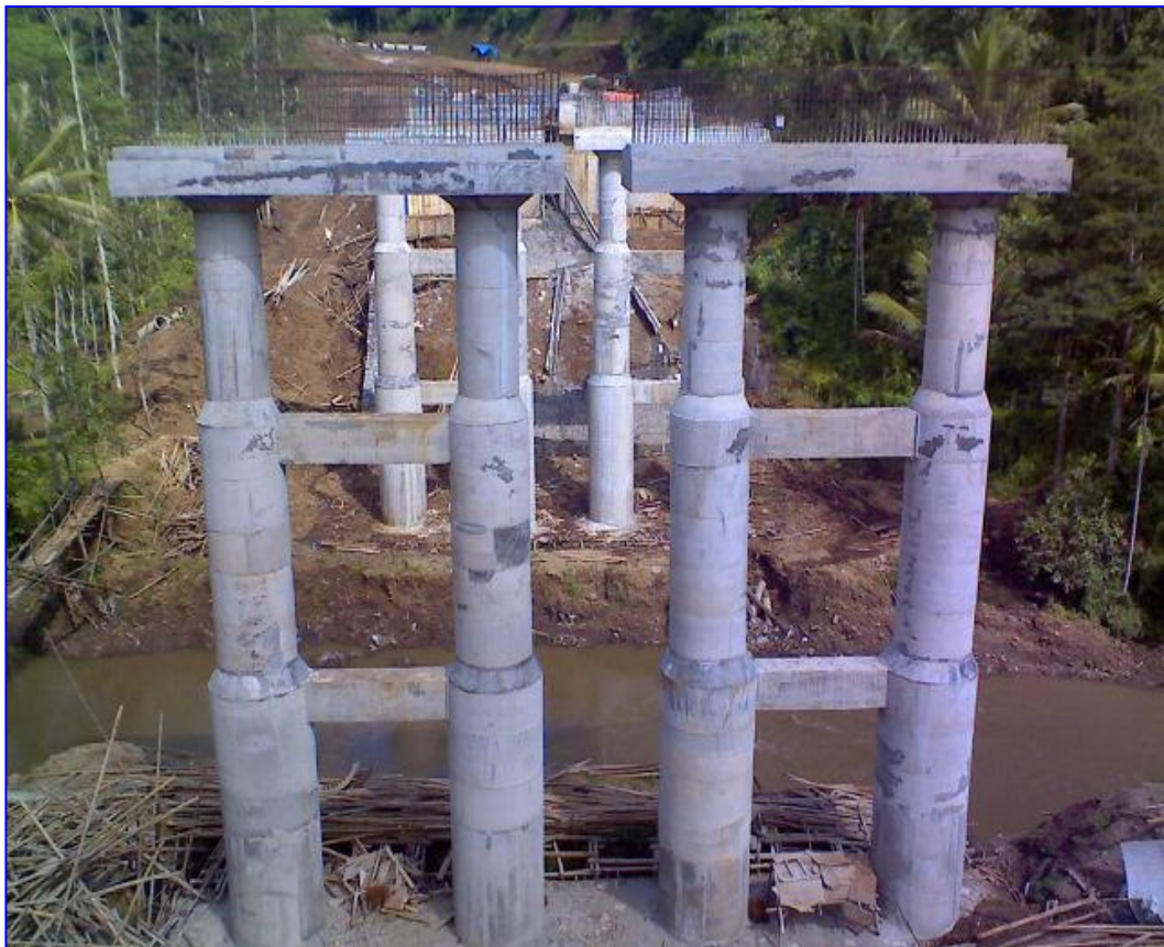
Gambar 15. Gambar proses pengerjaan jalibar tahap 1 Sumber: Dokumentasi Dinas Bina Marga Kab. Malang
