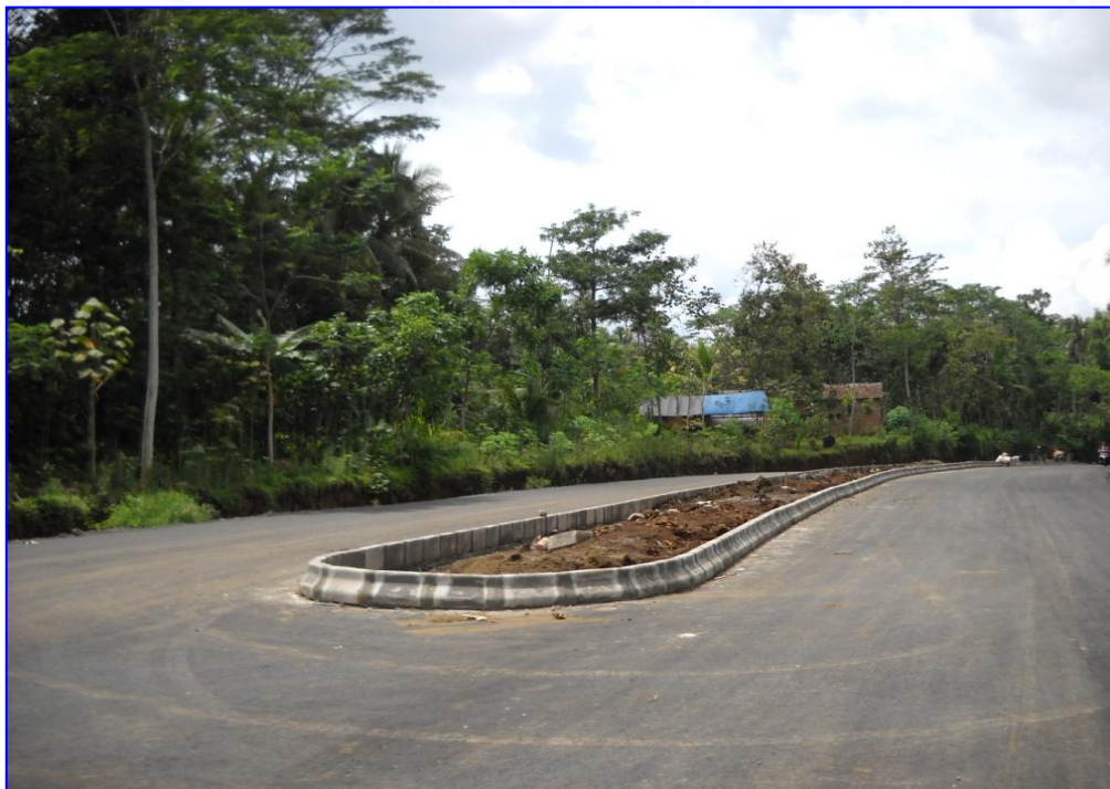
Gambar 19. Gambar jalan lingkar barat tampak kearah Talangagung
