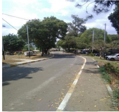
Gambar 12. Kondisi Jalan Menuju Wisata
