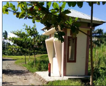
Gambar 6. Potret bangunan loket administrasi di Pasar Ternak Simpang Tigo Ophir
