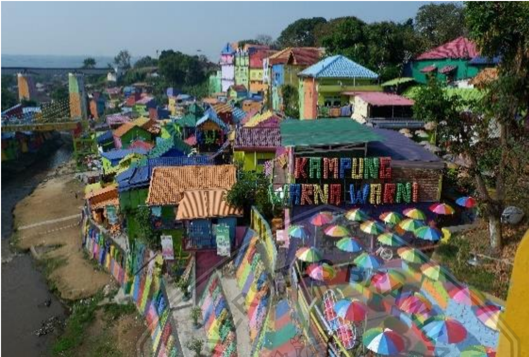
Gambar 4. 3 Dinding rumah penduduk
