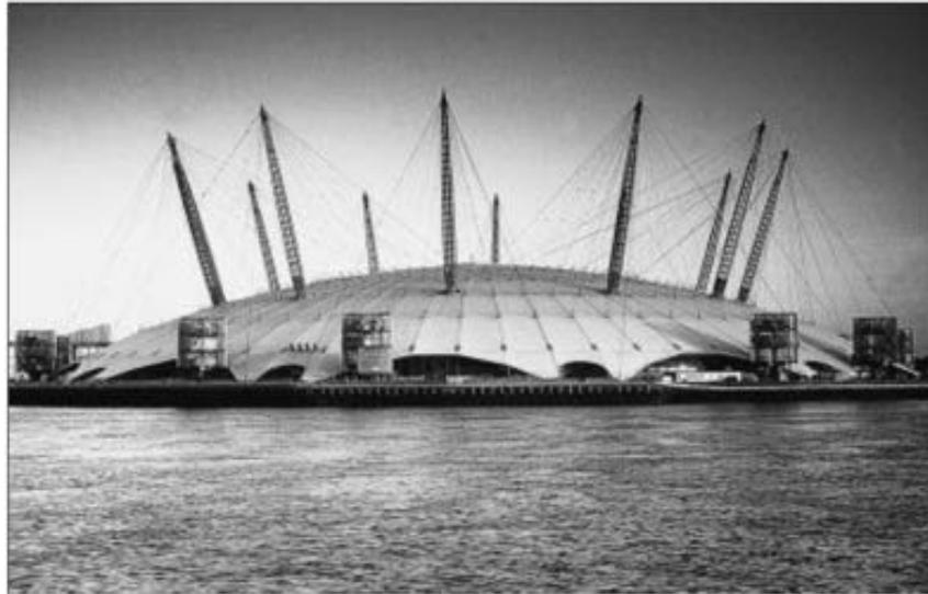
Gambar 2.2.2 Contoh Aplikasi Struktur Jaringan Kabel Pada Millennium Dome London 1999
