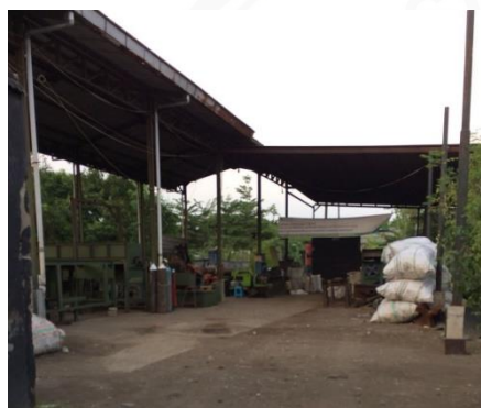
Gambar 4.5 Bangunan pada titik 2 TPST Bhakti Bumi II
