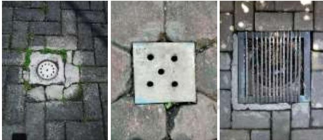
Gambar 4. 23 Biopori ukuran standar (kiri), jumbo (tengah), super jumbo (kanan)
