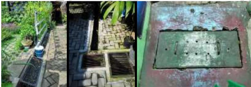
Gambar 4. 24 Parit resapan (1) (kiri), parit resapan (2) dan bak kontrol resapan (tengah), sumur injeksi (kanan)
