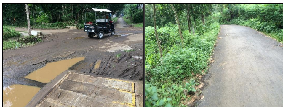
Gambar 4.23 Kondisi jaringan jalan: (a) Buruk dan (b) Baik
