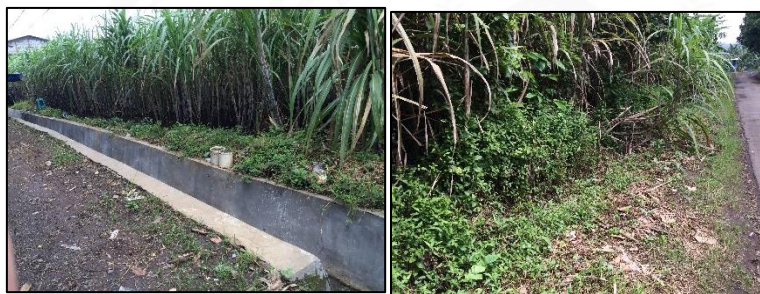
Gambar 4. 27 Kondisi jaringan irigasi (a) Baik dan (b) Buruk
