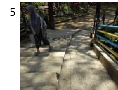
Tangga Pada area jembatan setelah pintu masuk
