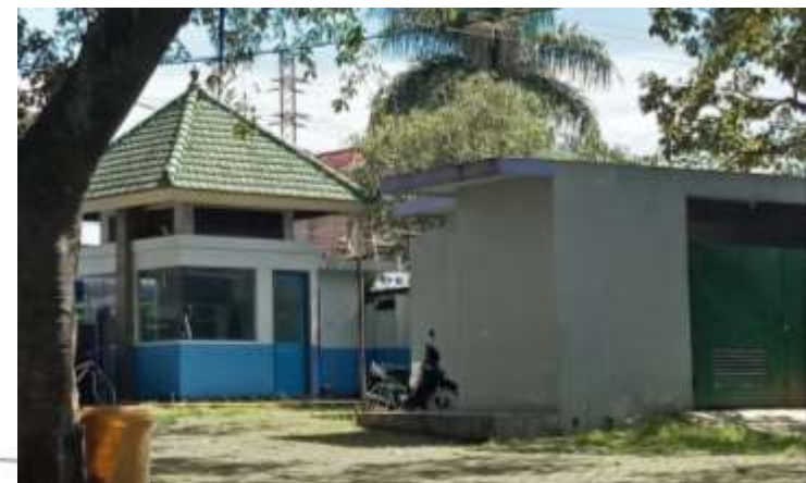
Pos satpam dan bangunan utilitas
