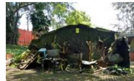
Bangunan yang sudah tidak digunakan kembali
