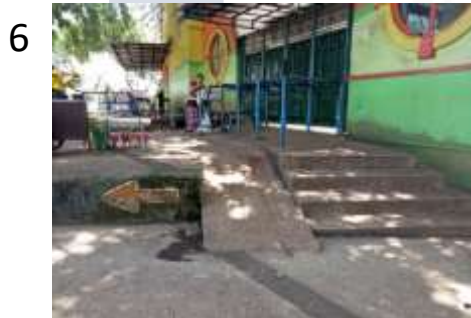
Tangga menuju pintu masuk
