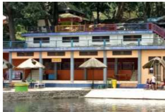
Kios jualan dan toilet untuk pemandian dekat dengan kolam alami
