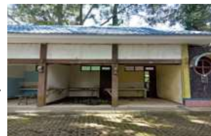
Kios makanan yang sudah tidak digunakan kembali, dan toilet
