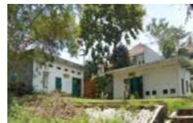
Bangunan gardu dan MEE
