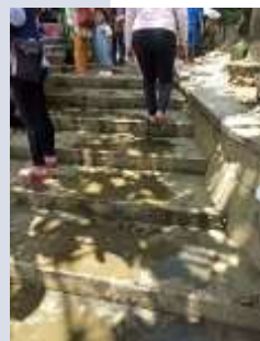
Tangga jembatan menuju pendopo dari area kolam anak
