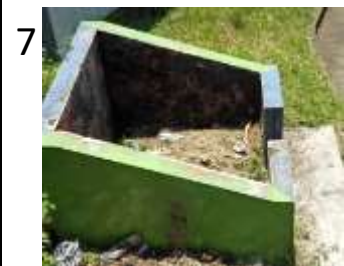
7 Bak sampah dari beton
