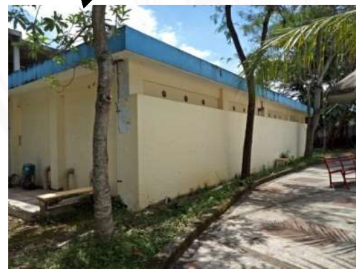
Ruang Utilitas untuk air di area waterboom
