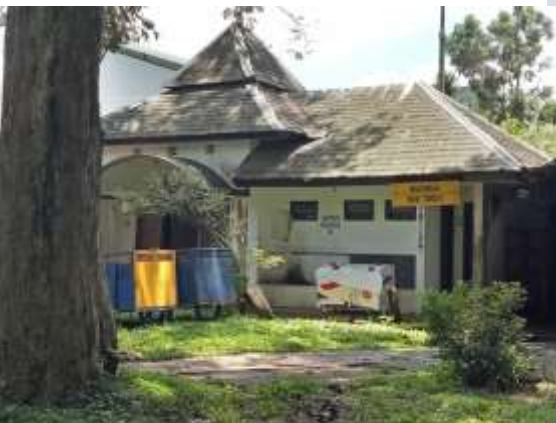
Masjid dan Toilet di Pasar Wisata
