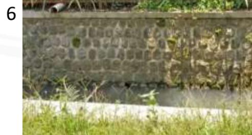
Saluran air dengan lebar 2 meter dan kedalaman 1.5 meter. Dinding saluran air terbuat dari batu kali
