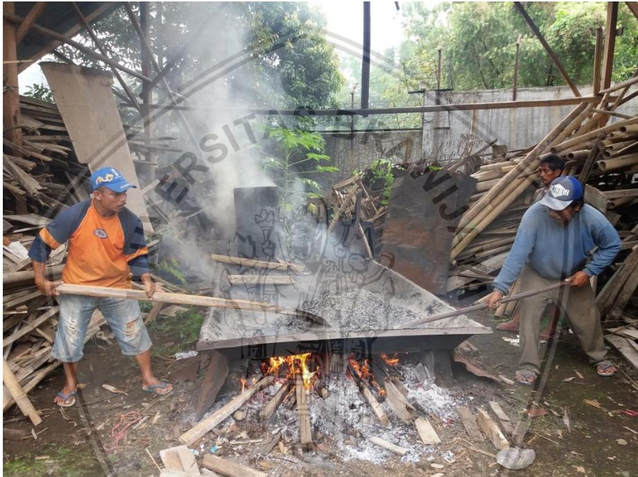
Gambar 4. 18 Proses Pencampuran Agregat dengan Aspal Cair
