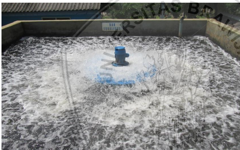
Gambar 4.36. Bak Equalisasi Sumber : dokumentasi pribadi
