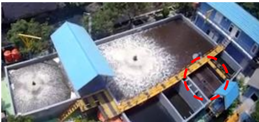
Gambar 4.44. Bak Sedimentasi Sumber : olahan peneliti
