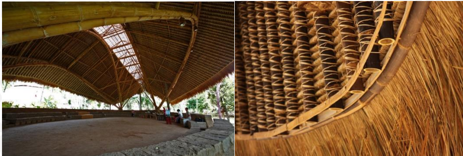
Gambar 2.39 Bambu Sebagai Elemen Struktural dan Arsitektural Sumber: www.designboom.com
