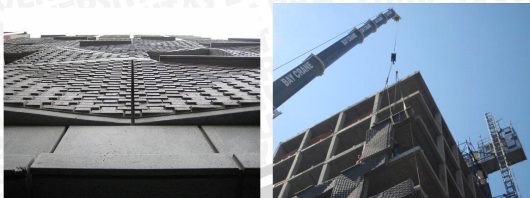
Gambar 2. 8 Dinding fasad prafabrikasi Sumber : www.archdaily.com
