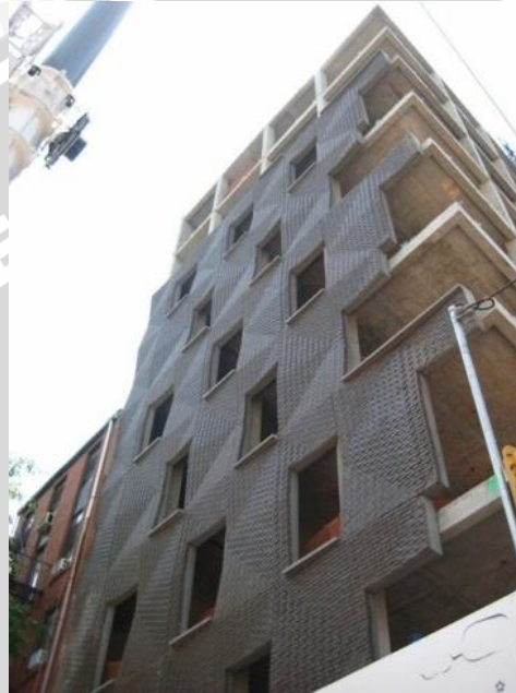
Gambar 2. 7 Pemasangan dinding prafabrikasi Sumber: archdaily.com
