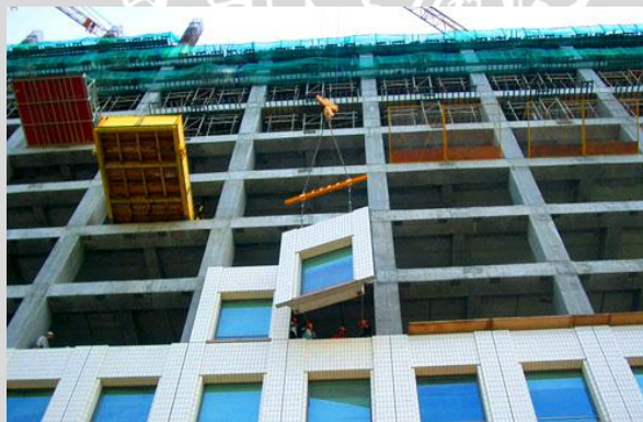
Gambar 4. 49 Pemasangan precast wall panel Sumber: google image
