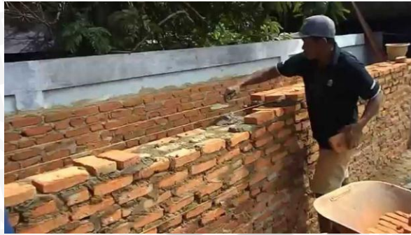
Gambar 4. 48 Pemasangan batu bata merah konvensional Sumber: google image
