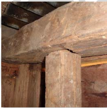
Sambungan purus pada ri'i ese dan pangere , purus menembus atau dapat juga menonjol. Tidak terdapat wole untuk mengunci sambungan.
