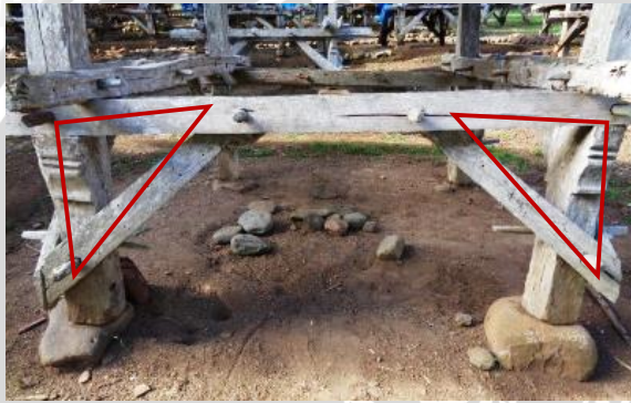
Tiga elemen konstruksi wombo yang membentuk segitiga ( ri'i-ceko-nggapi ).
