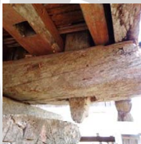
Gambar 4.65 Detil konstruksi pada titik 2, sambungan ri'i ese-sambanta
