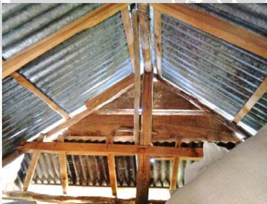
Gambar 4.78 Perbedaan konstruksi taja dengan dan tanpa manini
