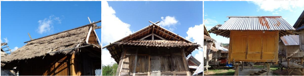
Ragam butu yang dihasilkan dari perbedaan material. Jompa no.85 (kiri) menggunakan ndolo . Pada no.68 (tengah) contoh menggunakan genteng. Penggunaan butu seng pada Jompa no.29 (kanan).
