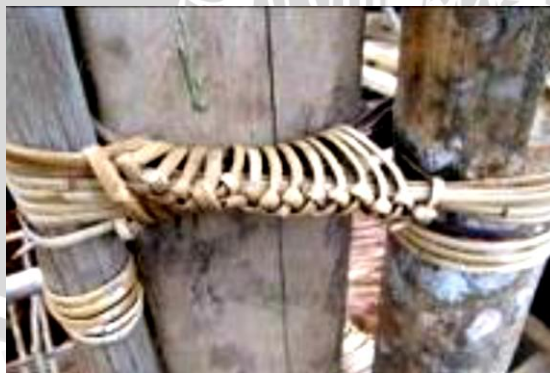
Gambar 2.10 Ikatan pada struktur di rumah tradisional di Kampung Wae Rebo (sumber: Damayanti, 2014 )
