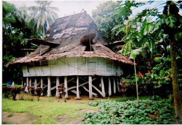
Gambar 2.2 Pondasi Batu pada Rumah Omo Hada, Nias (sumber: Lumantara, 2013)
