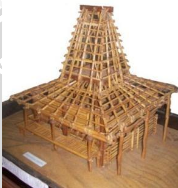
Gambar 2.5 Konstruksi atap pada Rumah Kampung Tarung, NTT (sumber: Nurdiah et al, 2011)
