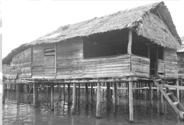
Gambar 2.11 Pondasi dan dinding rumah tradisional Suku Bajo terbuat dari kayu (sumber: Rifai, 2010)
