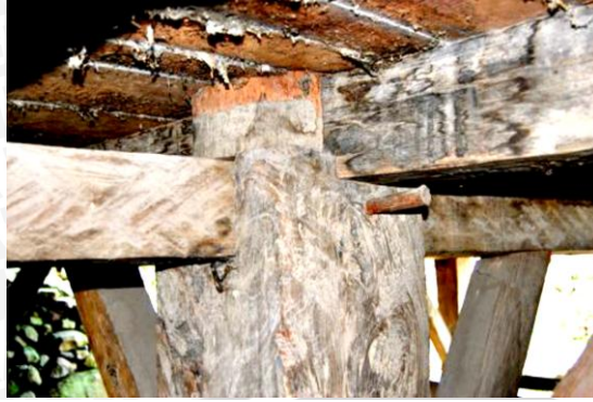
Gambar 2.9 Sambungan pen dan pasak pada kaki dan balok rumah di Kampung Ruteng Pu'u (sumber: Damayanti, 2014 )
