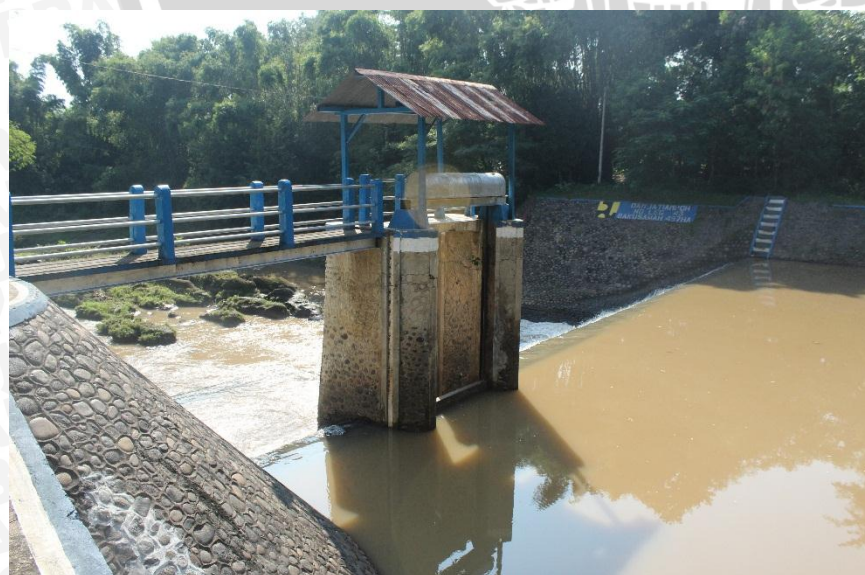
Gambar 3.3 Bendung Jati Ampuh
