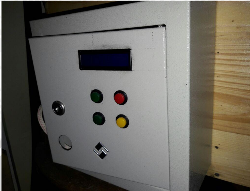
Gambar 3. Foto Box Kontroller
