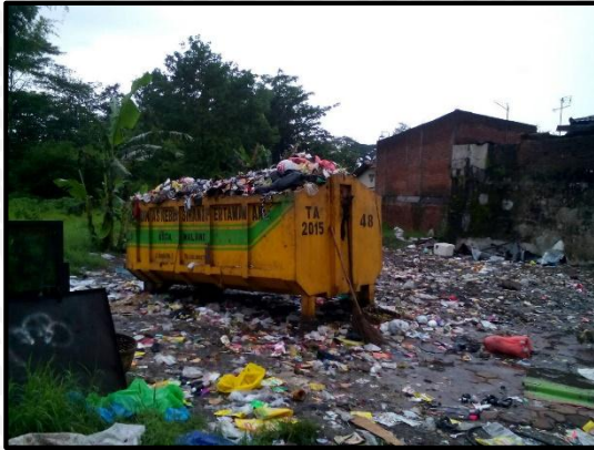
Gambar 1. 4 TPS Bandulan tidak dilengkapi landasan gerobak dan landasan kontainer
