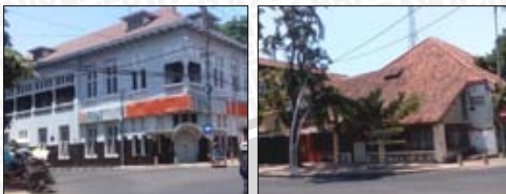
Gambar 4. 11 Bangunan rendah dengan ketinggian 1-2 lantai di kawasan Jembatan Merah
