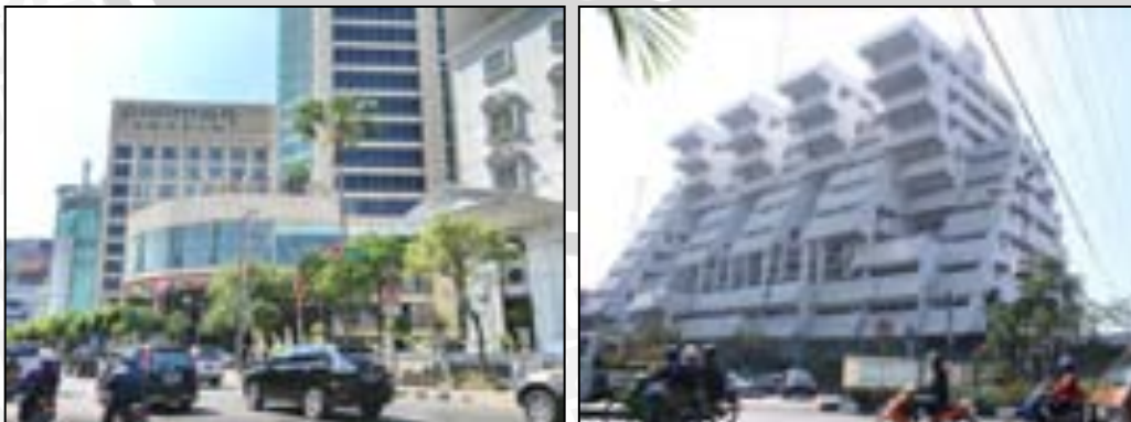
Gambar 4. 1 Bangunan dengan ketinggian lebih dari 8 lantai di Kawasan Tunjungan
