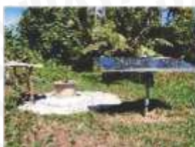
Pompa Air Tenaga Surya
