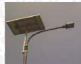
Lampu Jalan Tenaga Surya
