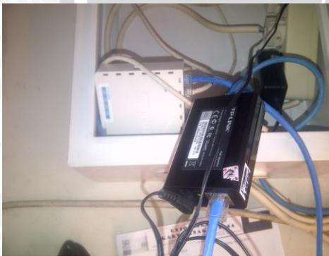
Gambar 3. 15 Pemasangan PoE *access point* di dalam pos pengamanan
