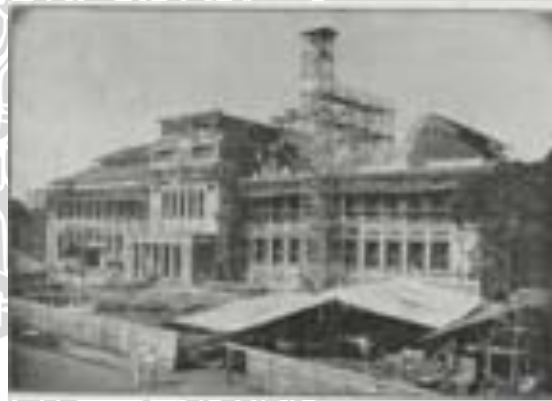
Gambar 4.4 Pemasangan Beton dan Kap Besi Sumber: Indisch Bouwkundig Tijdschrift
