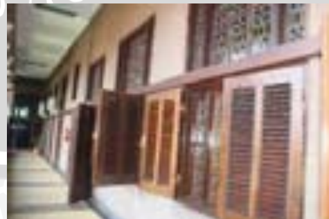
Gambar 4.60 Pintu dan Jendela pada Selasar Lantai 2 Sumber: Dokumentasi Pribadi
