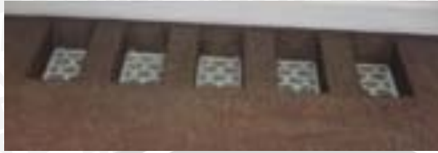
Gambar 4.54 Ventilasi Dinding Atas Sumber: Dokumentasi Pribadi
