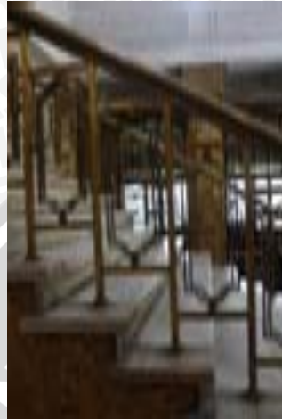
Gambar 4.24 Susunan Tangga Utama Sumber: Dokumentasi Pribadi
