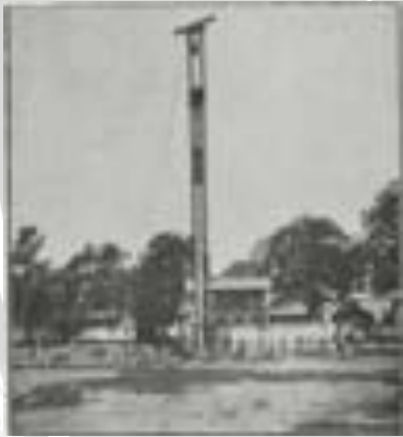
Gambar 4.3 Pemasangan Beton Pertama Sumber: Indisch Bouwkundig Tijdschrift
