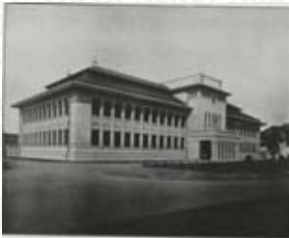
Gambar 4.5 Bagian Depan Gedung HVA Sumber: Indisch Bouwkundig Tijdschrift
