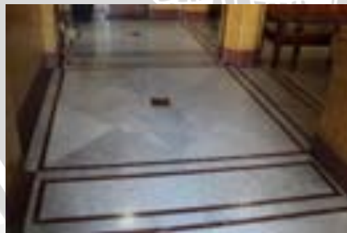
Gambar 4.35 Lantai Lobi Lantai 2 Sumber: Dokumentasi Pribadi
