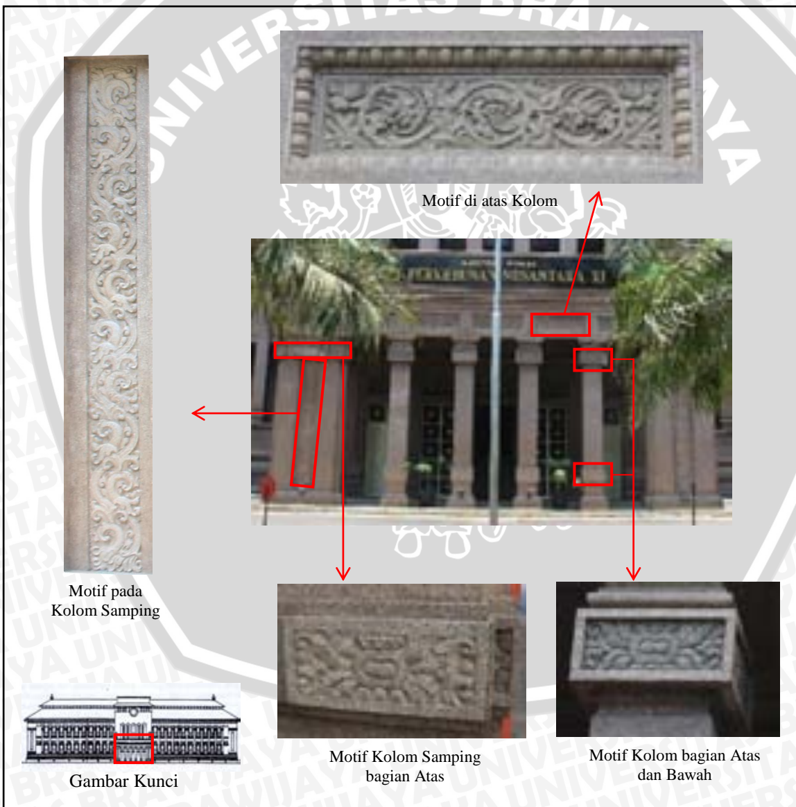
Gambar 4.62 Tampak Depan Drop-Off Gedung PTPN XI Sumber: Dokumentasi Pribadi
