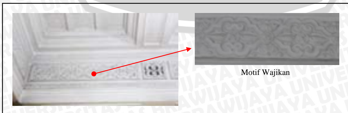
Gambar 4.32 Plafon Pinggir Sumber: Dokumentasi Pribadi
