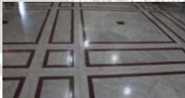
Gambar 4.17 Lantai Lobi Lantai 1 Sumber: Dokumentasi Pribadi
