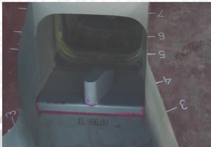
Kondisi inlet terowong pada perubahan seri 4
