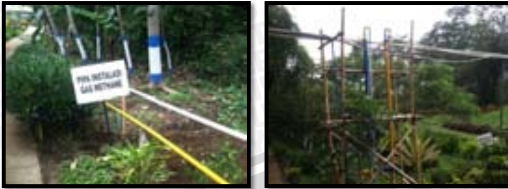
Gambar 4. 10 Pipa Distribusi Biogas TPA Paras Desa Karangnongko
