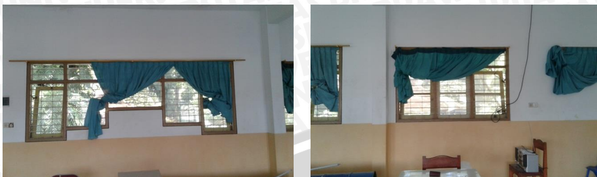
Gambar 4.47 Ruang Kelas H
