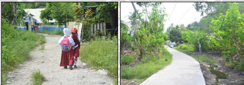
Gambar 4. 23 Kondisi Jalan di Pulau Battoa, Desa Tonyaman Sumber : Survei Primer, 2016
