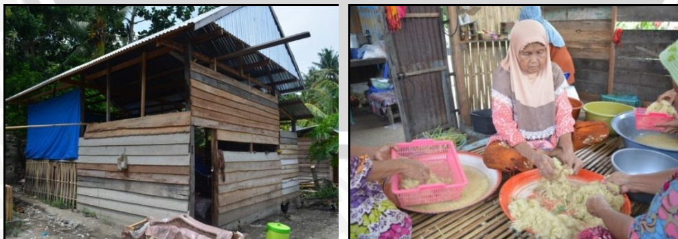
Gambar 4. 12 Bangunan industri pengolahan dan aktivitas pengolahan Kelompok Bahari Indah
