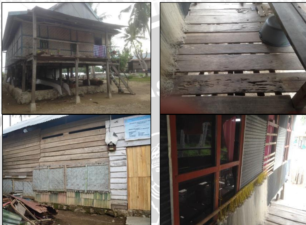
Gambar 4. 46 kondisi dinding dan lantai rumah masyarakat pesisir Desa Tonyaman Sumber: Hasil Survei, 2016
