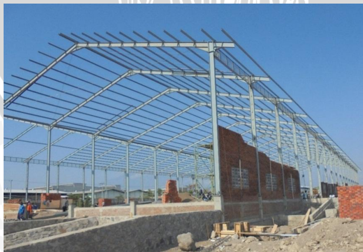
Gambar 4.1 Foto Pemasangan Gording.
