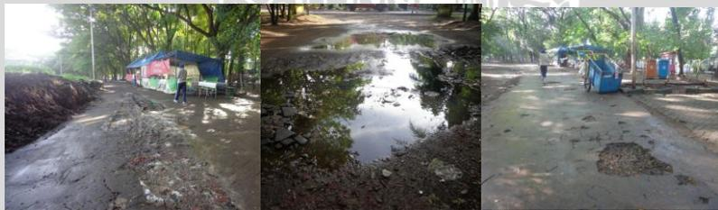
**Gambar 4. 10 Kondisi Perkerasan Sirkulasi yang Rusak**
