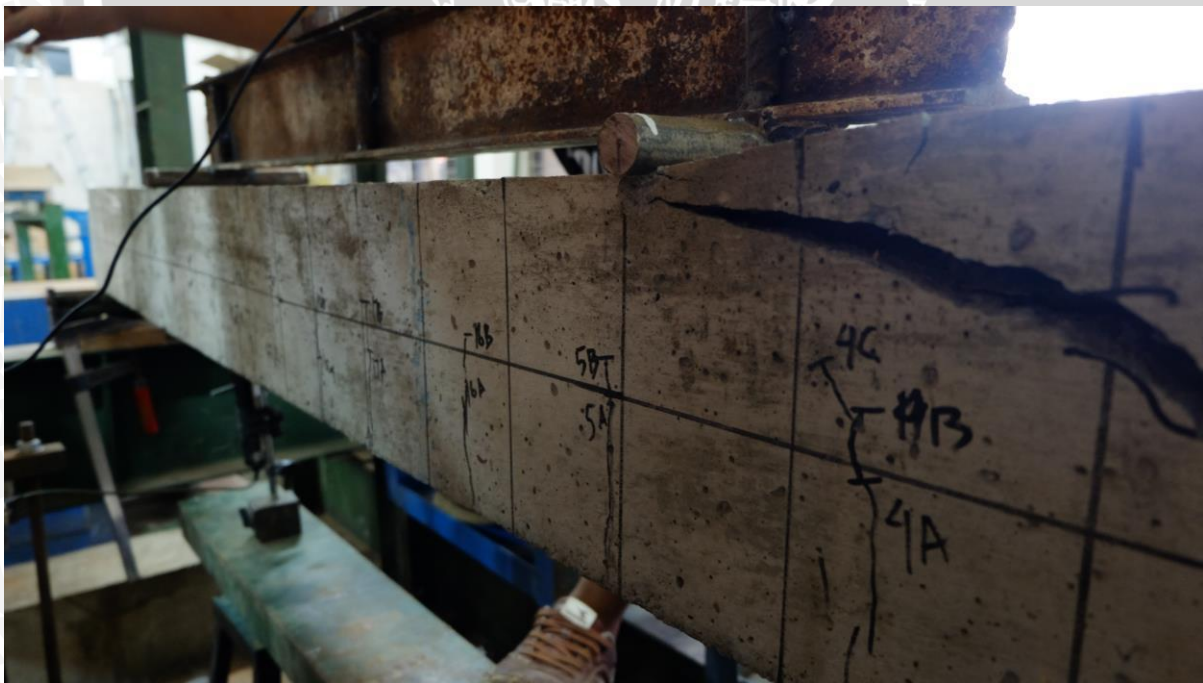
Keterangan : Runtuh geser pada balok Hollow Core ukuran 5 cm
