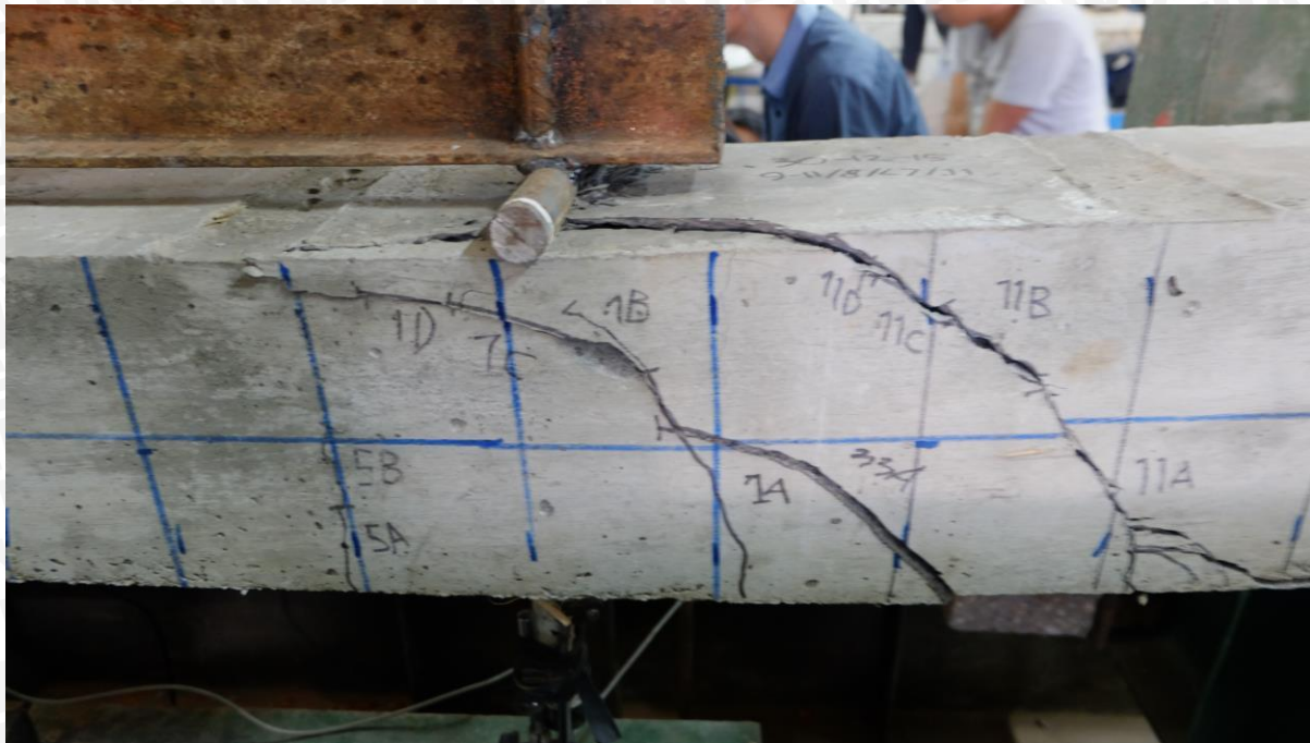
Keterangan : Runtuh geser pada balok Normal
