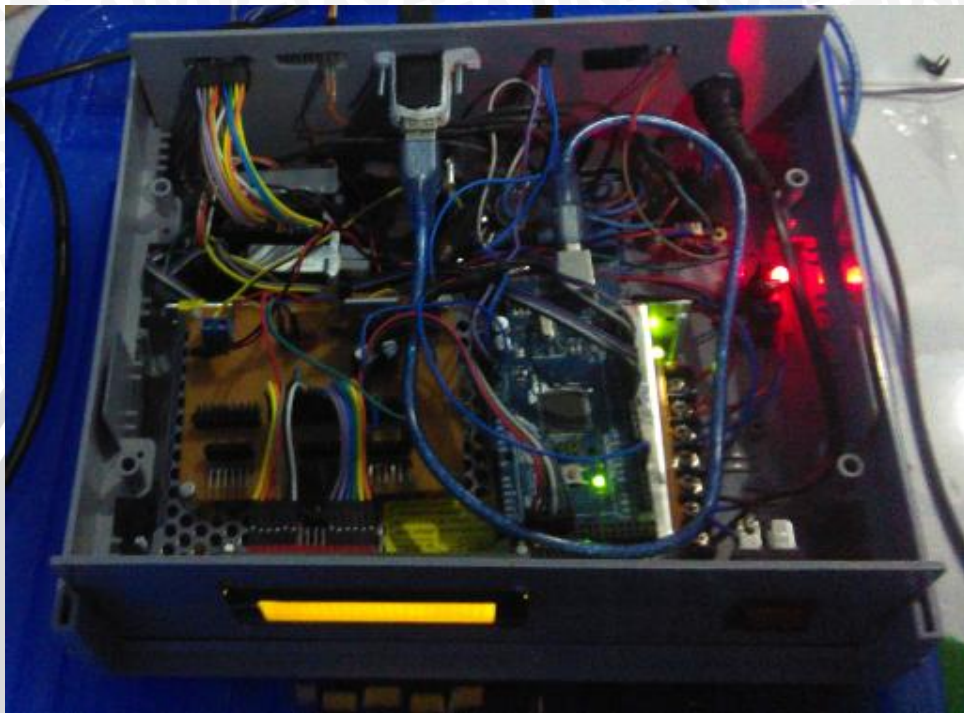
Box tempat komponen elektrik diletakkan
