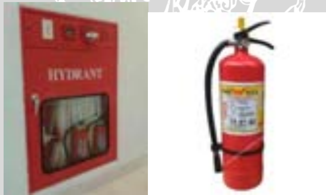
gambar 4. 119 hidran dan APAR
