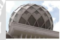
Point of interest material terdapat pada atap kubah GRC (Glassfibre Reinforced Cement).
