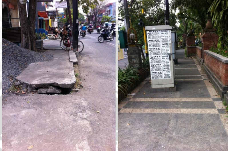
Gambar 1. 2 Hambatan pada Jalur Pejalan Kaki
