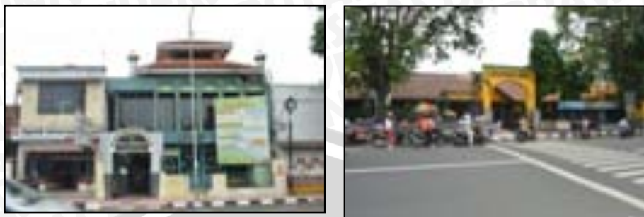
Gambar 4.16 Kondisi Eksisting Sarana Pendidikan di Jalan Trunojoyo
