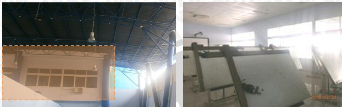
Gambar 4.29. Eksterior dan Interior Ruang Kelas Gambar
