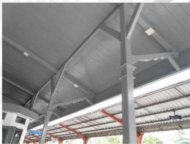
Dinding setengah gevel yang menopang atap pelana sayap bangunan, didukung oleh kolom kayu dengan konstruksi konsol seperti bentuk payung. Jarak antar kolom kayu tersebut adalah 4 m.
