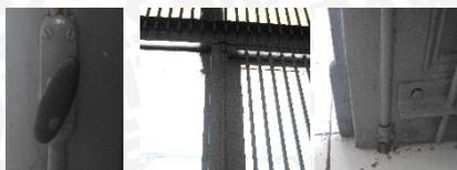
Sisi dalam pada salah satu daun pintu P3.1 memiliki *handle* yang dapat diputar. Putaran pada *handle* dapat menggerakkan batang besi pada daun pintu ke atas dan ke bawah, sehingga daun pintu ini dapat terkunci dari dalam.
