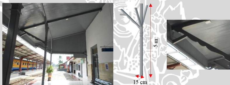
Gambar 11. Kolom kayu pada peron 1 Stasiun Jember.
