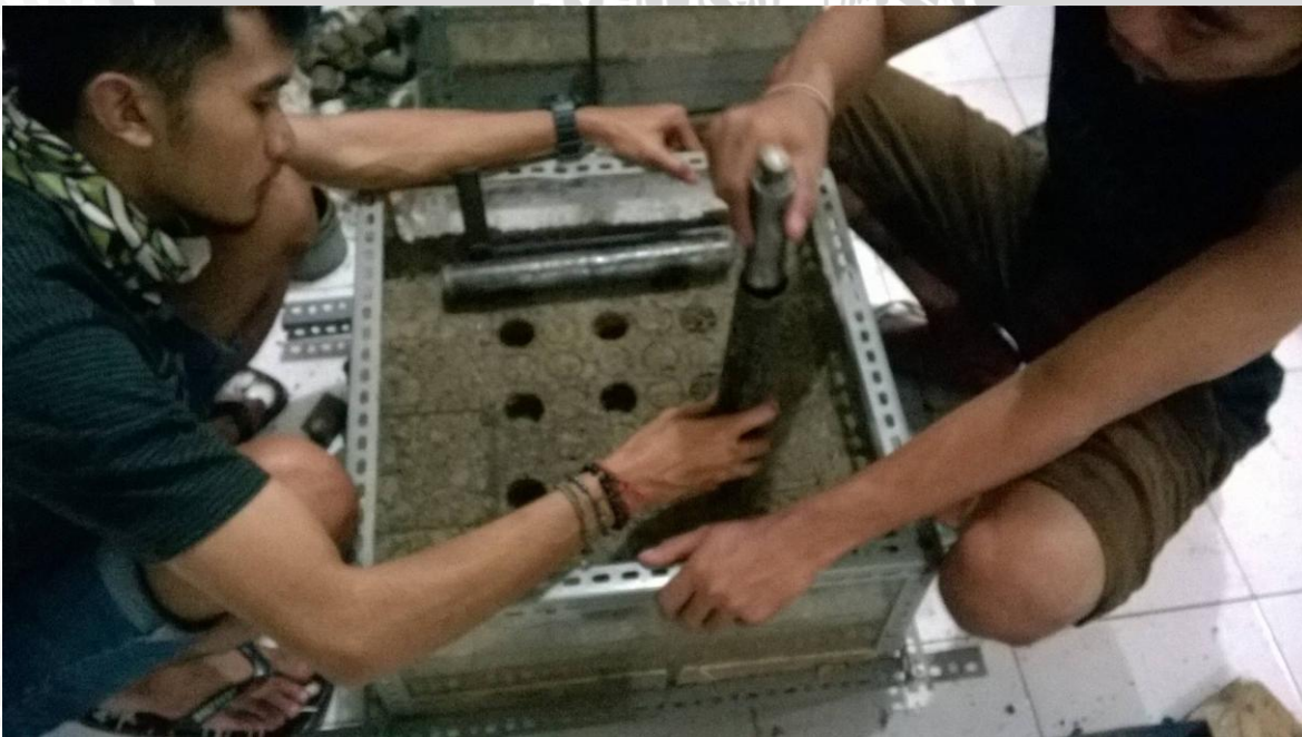
Gambar Instalasi Kolom DSM
