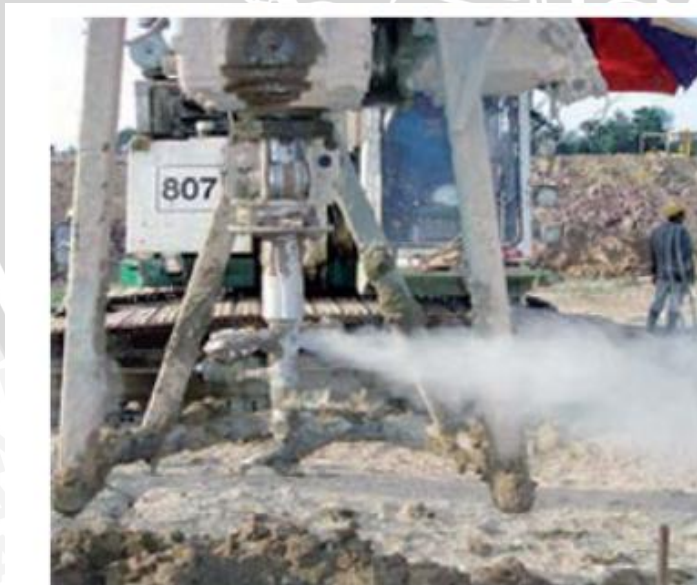
Gambar 2.21 Peyemburan pengikat kering dari alat pencampur (Keller)
