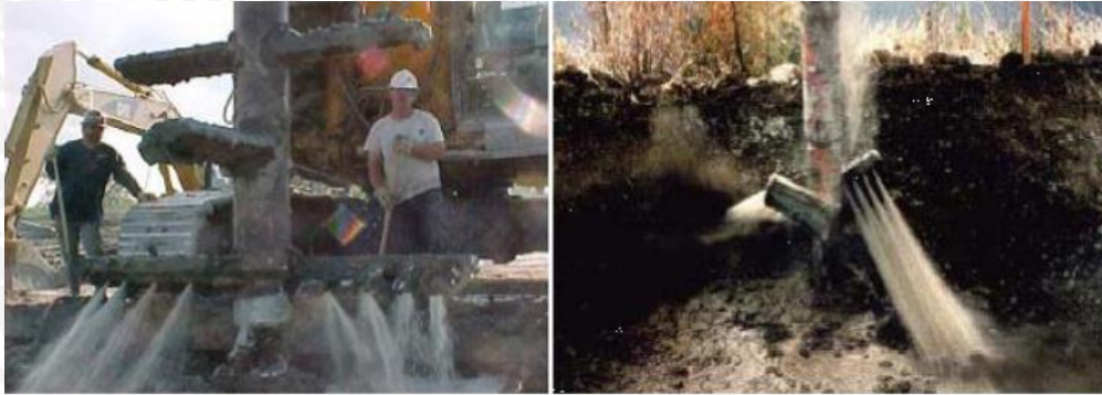
Gambar 2.20 Alat pencampuran basah (Porbaha et al, 2005)
