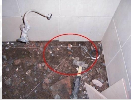
Gambar 2.2 Pemasangan garis bantu
