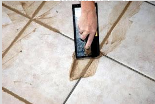
Gambar 2.6 Pemberian nat pada pemasangan keramik
