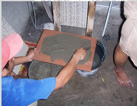
Gambar 2.3 Pengolesan semen ke belakang keramik
