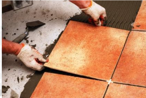
Gambar 2.5 Pemberian jarak saat pemasangan keramik
